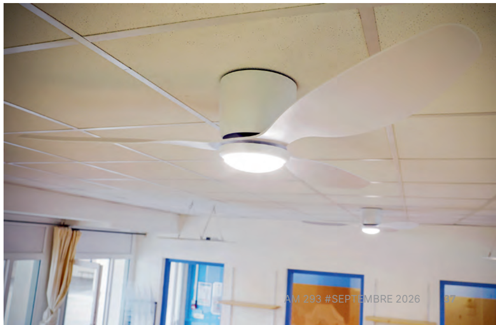
L'installation de brasseurs d'air est en cours dans toutes les écoles de la ville.
