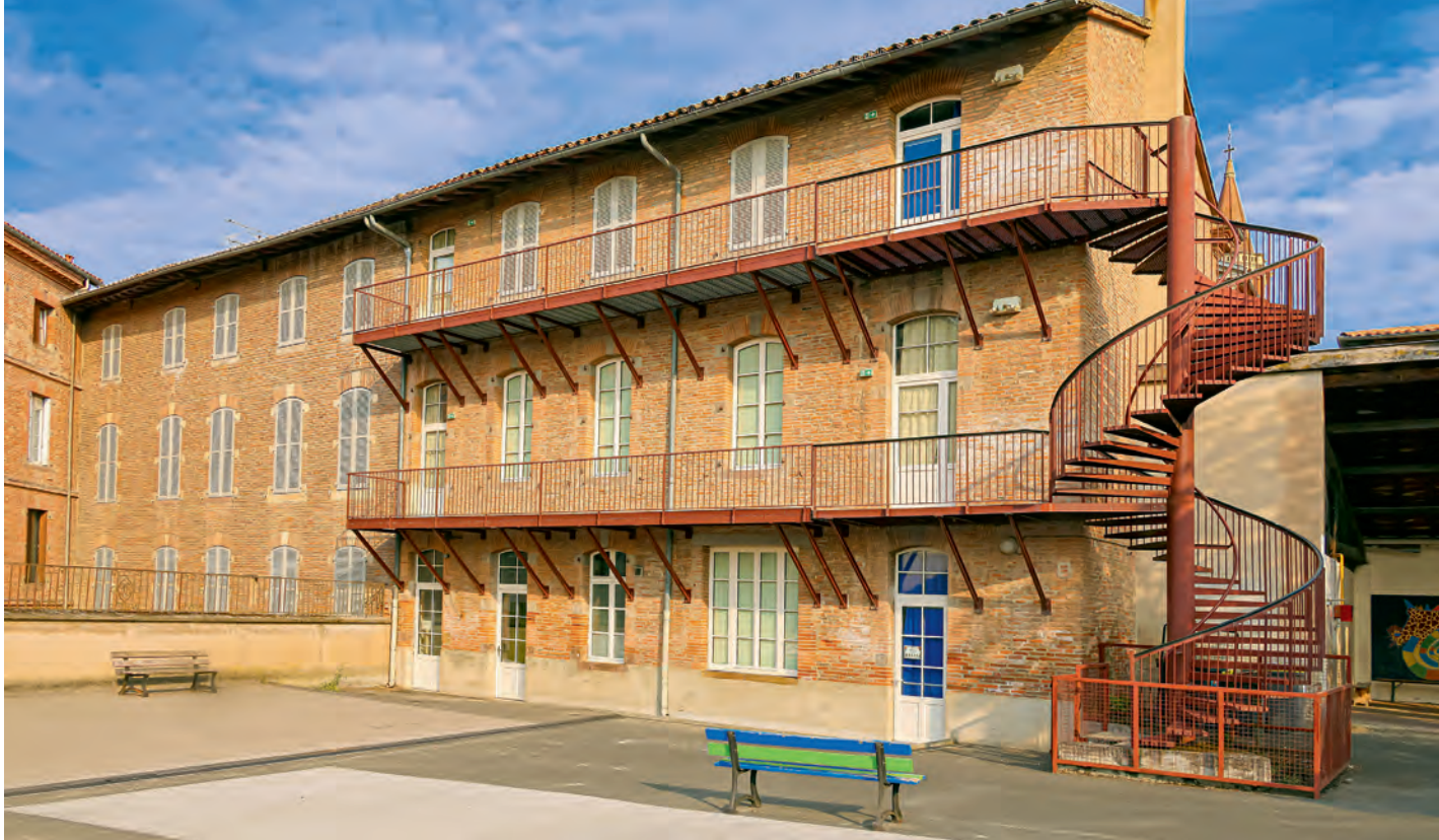
La pose de volets brise-soleil permet d'atténuer les effets du soleil dans les classes. Ici à l'école Lucie et Raymond Aubrac.
