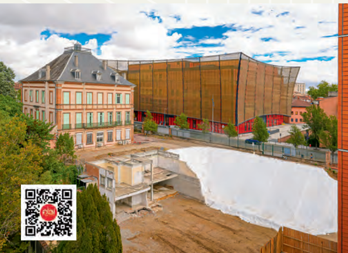
L'emplacement de la construction du nouveau bâtiment du musée est désormais dégagé.
