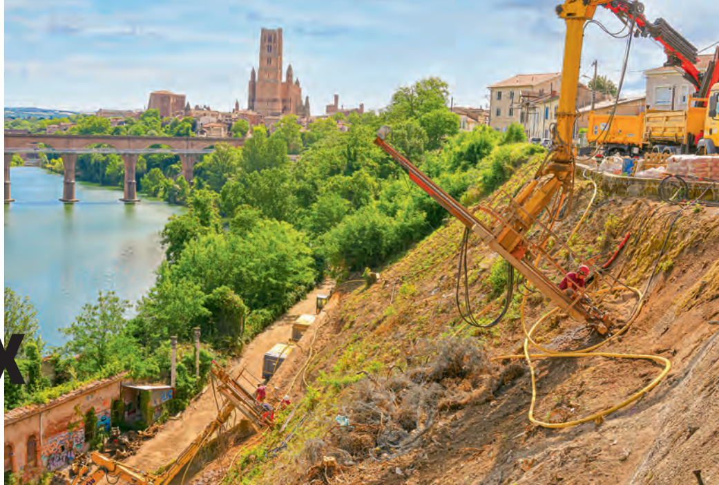
Importants travaux de confortement au niveau de la rue Gardès.
