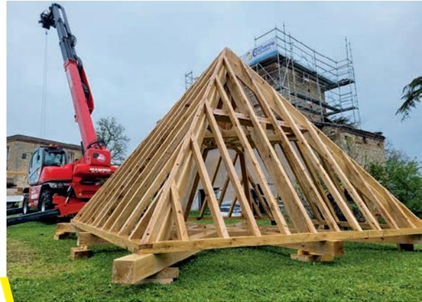
La charpente construite dans l'atelier albigeois a été remontée sur place avant d'être posée sur le pigeonnier.
