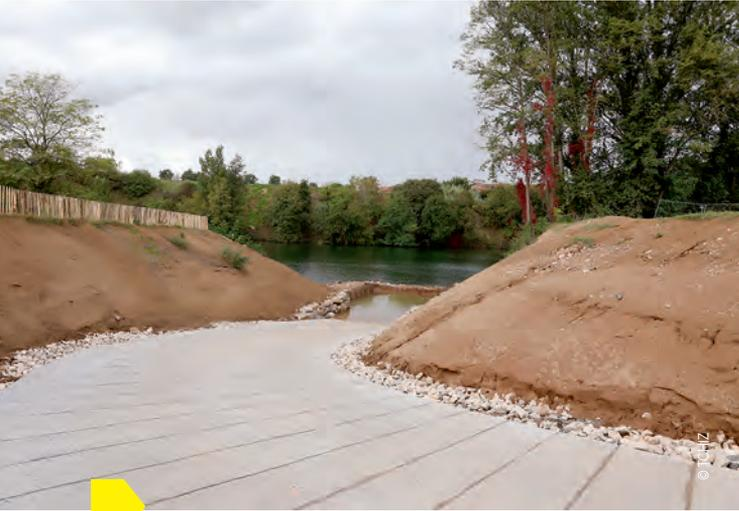
La réalisation de la cale a nécessité la mise en place d'un dispositif de palplanches enfoncées dans le sol à près de cinq mètres de profondeur afin de faciliter les travaux de terrassement à sec et garantir la stabilité des pieds de talus.
