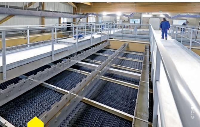
Après la coagulation et la floculation, la décantation permet aux particules de tomber au fond du bassin tandis que l'eau « clarifiée » est reprise en surface dans ces gouttières en inox.
