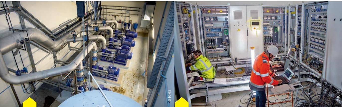
Dans ce local en sous-sol, l'eau potable est injectée dans le réseau grâce à trois pompes puissantes (les deux autres visibles sur la photo servent à nettoyer les filtres à sable). Sur place, l'eau est également stockée dans deux réservoirs de 1 500 m<sup>3</sup> enterrés.
