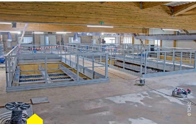
La station comprend deux lignes de production. L'eau brute transite d'abord dans des cuves de coagulation puis de floculation. Ces opérations sont assurées par des réactions chimiques et mécaniques en préalable de l'étape de décantation qui peut être considérée comme le cœur du traitement.
