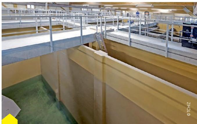
Étape suivante, l'eau est filtrée à travers une épaisse couche de sable qui retient les microparticules et affine encore le traitement. L'eau est récupérée par des buses situées au fond des filtres.
