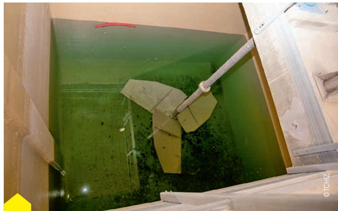
Au fond du bassin de coagulation, un agitateur, tel une hélice, brasse l'eau rapidement, contrairement au bassin de floculation dans lequel l'opération est réalisée lentement.
