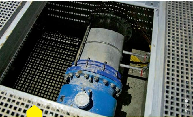
La canalisation est dissimulée sous une grille... C'est de là qu'arrive l'eau « brute » prélevée dans le Tarn. En moyenne, à la mise en service, 15 000 m<sup>3</sup> seront pompés par jour. La capacité maximale de traitement de la station est de 30 000 m<sup>3</sup> par jour, de quoi absorber l'augmentation de la population dans les années à venir.
