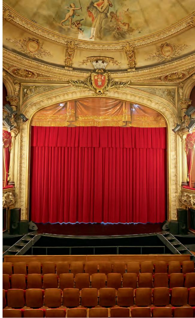
*La scène de dix mètres de profondeur pour huit mètres d'ouverture et cinq de hauteur (onze mètres au total avec le grill) offre un bel espace de jeu. Pour l'anecdote, le plancher est en pente de 4 % afin de faciliter la vue du public.*
